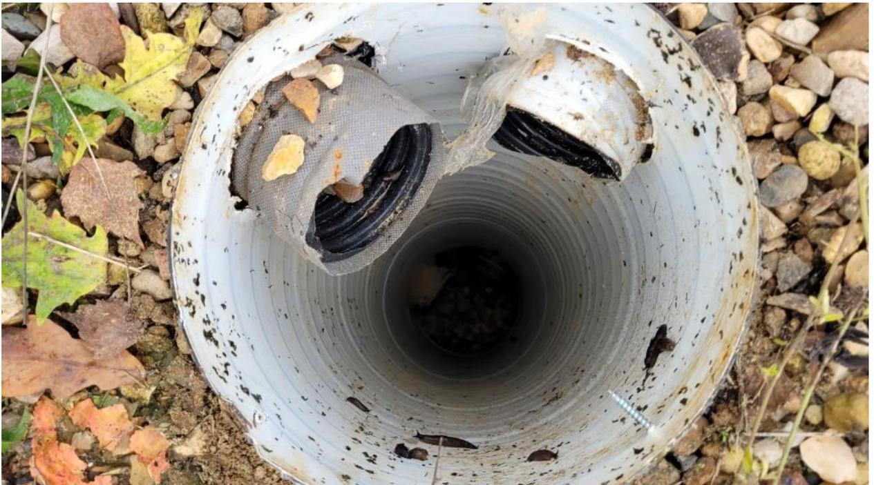
Фото 17. Вводы дренажных труб в смотровые колодцы не уплотнены специальными манжетами. Из-за допущенного дефекта грунты свободно вымываются в смотровые колодцы и забивают их.
