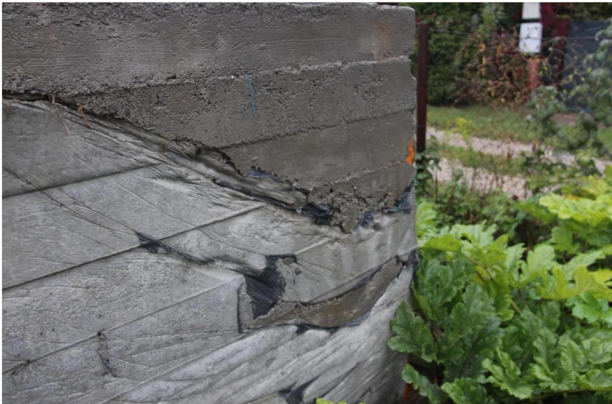
Фото 1. Дефект бетонирования подпорной стены. Холодный шов бетонирования
