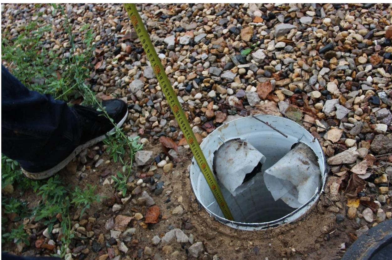
Фото 2. Измерения параметров водосборной камеры системы дренажа. Глубина дренажа составляет 1,2 метра от уровня земли вместо заявленных 1,5 метра.
