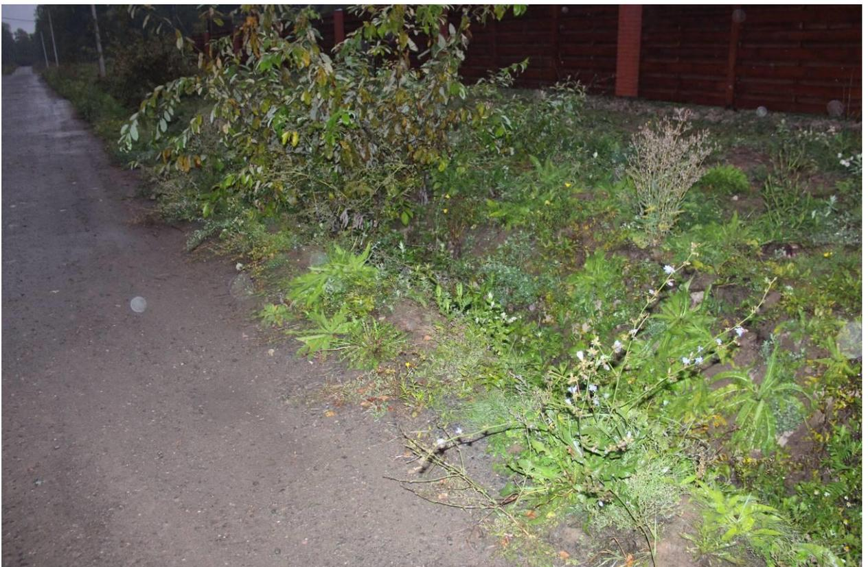
Фото 4. Общий вид. Кюветы. Небольшой отвал грунта выполнен между дорогой и кюветом, который полностью исключает стекание воды с дороги в кюветы.
