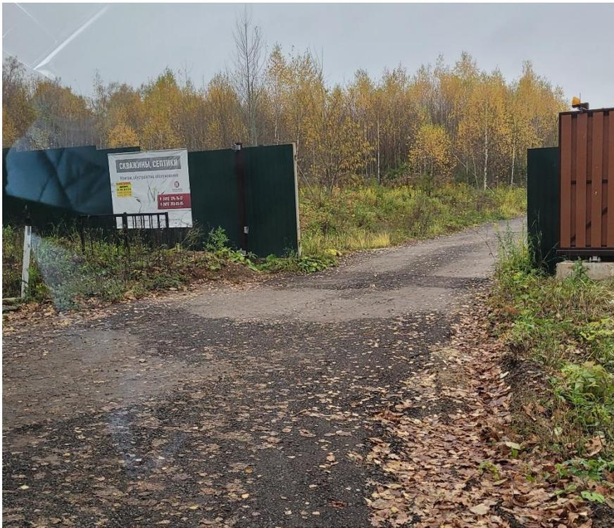
Фото 15. На поверхности дорог в зоне проложенных водопропускных труб образованы крупные провалы грунта, которые на момент осмотра уже частично отремонтированы (присыпаны новым грунтом).
