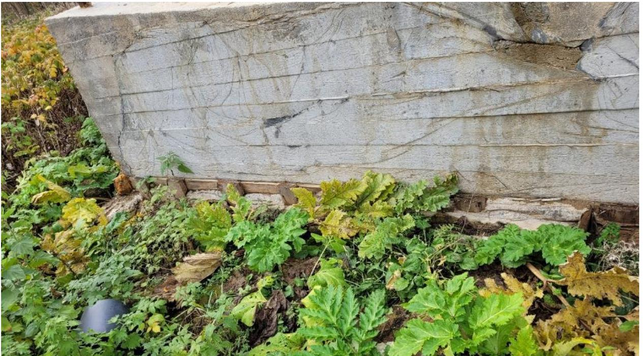
Фото 24. С бетонной подпорной стены спортивной площадки не была демонтирована дощатая опалубка, а просто для скрытия дефекта присыпана грунтом.
