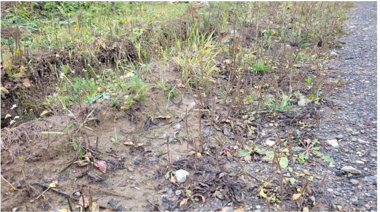
Фото 13. Вдоль разработанных кюветов повсеместно образованы навалы грунта, которые препятствуют свободному стоку воды с поверхности дорог и проездов.
