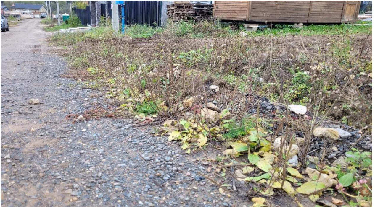
Фото 11. Вдоль разработанных кюветов повсеместно образованы навалы грунта, которые препятствуют свободному стоку воды с поверхности дорог и проездов.
