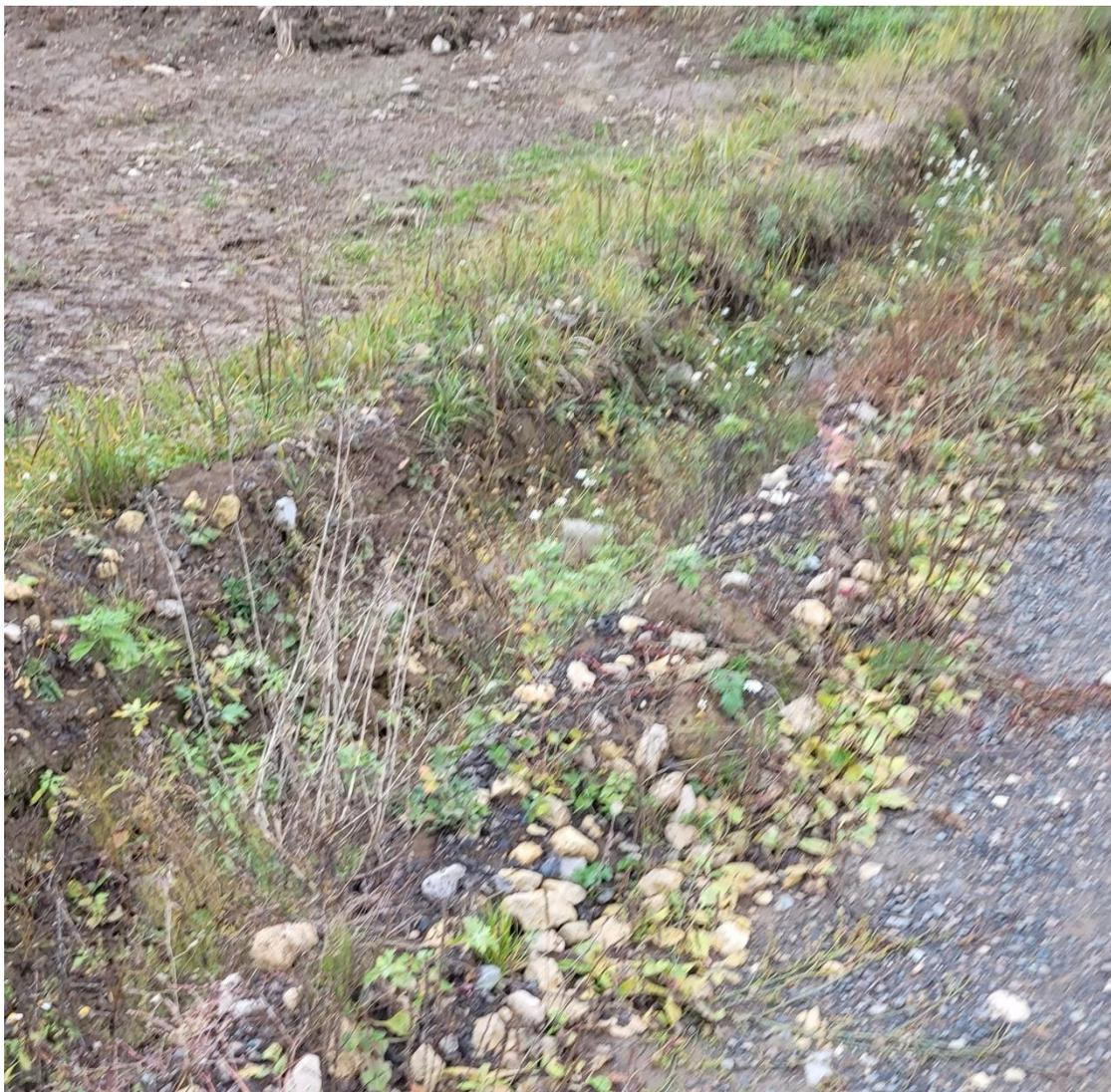
Фото 10. Вдоль разработанных кюветов повсеместно образованы навалы грунта, которые препятствуют свободному стоку воды с поверхности дорог и проездов.
