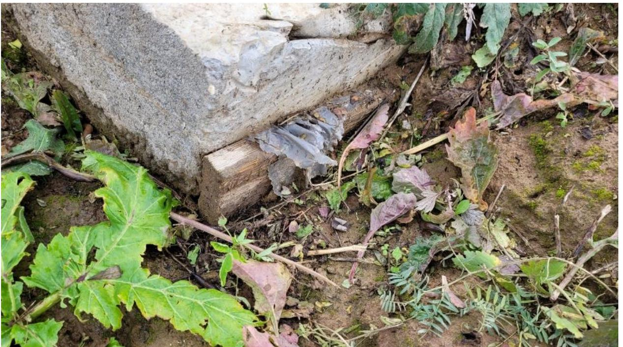
Фото 22. С бетонной подпорной стены спортивной площадки не была демонтирована дощатая опалубка, а просто для скрытия дефекта присыпана грунтом.
