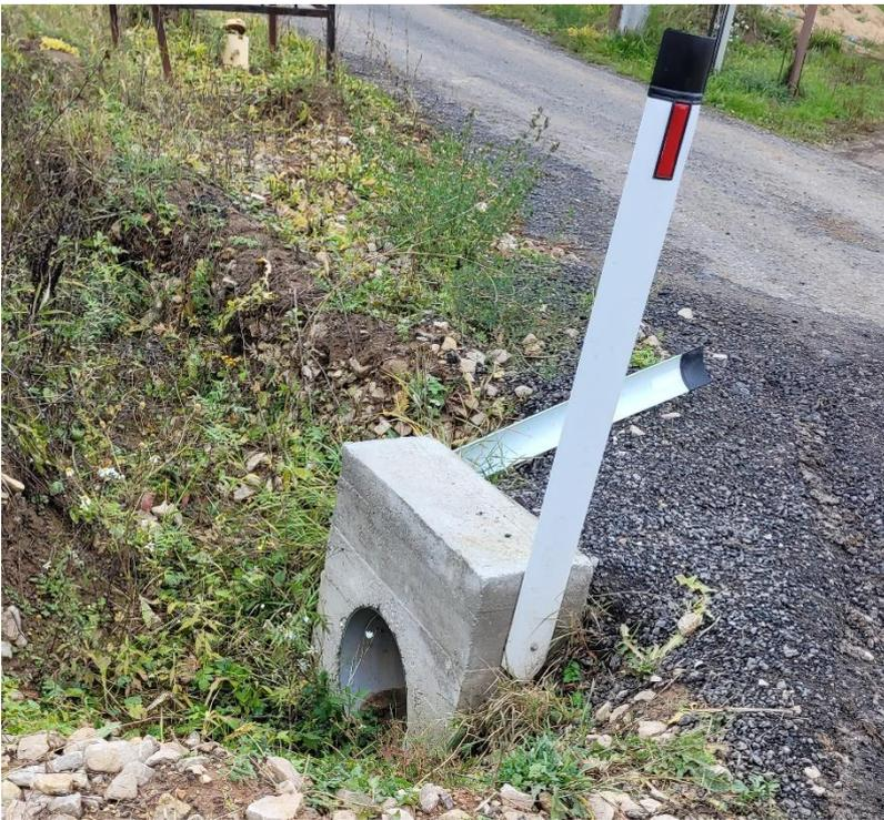
Фото 7. Сигнальные столбики на всех бетонных оголовках закреплены только на один дюбель-болт, на котором не держатся и повсеместно падают
