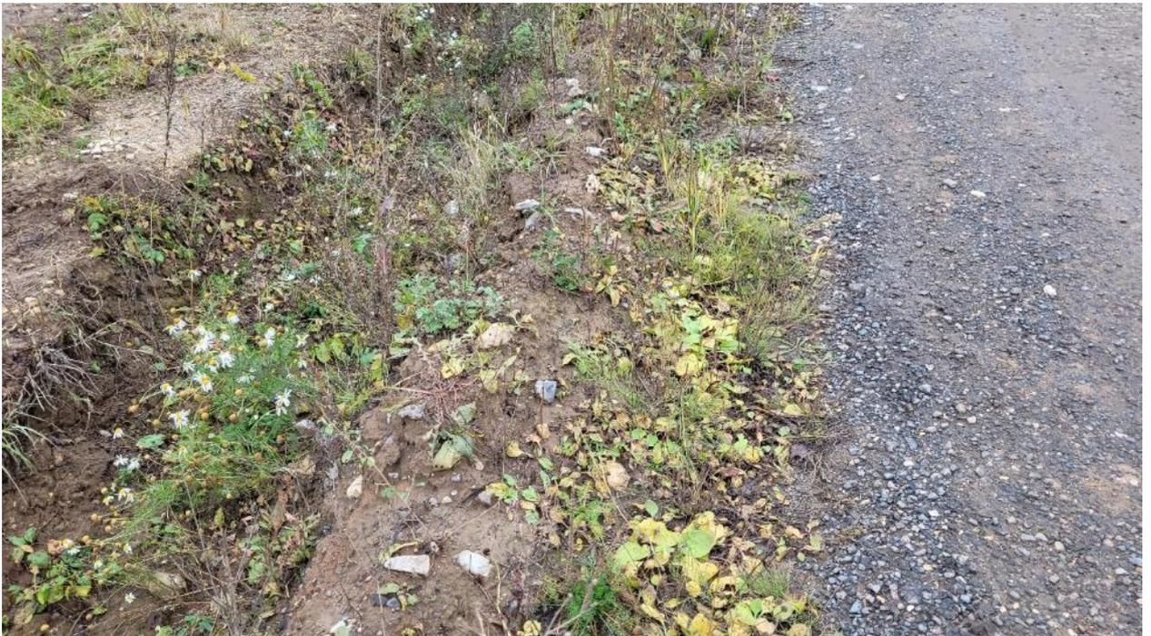
Фото 12. Вдоль разработанных кюветов повсеместно образованы навалы грунта, которые препятствуют свободному стоку воды с поверхности дорог и проездов.
