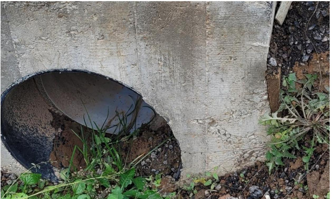
Фото 8. На поверхности бетонных оголовков повсеместно образованы крупные раковины, деревянная опалубка не была своевременно демонтирована с оголовков, а просто присыпана грунтом для скрытия дефекта.
