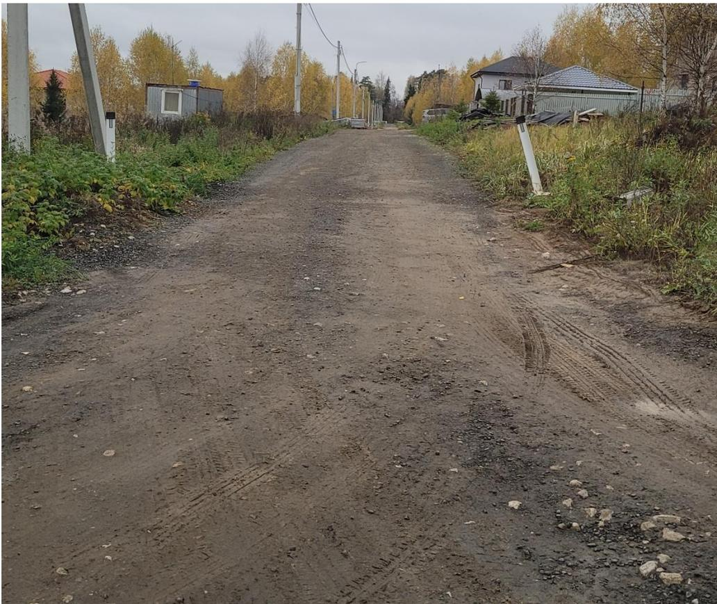
Фото 14. На поверхности дорог в зоне проложенных водопропускных труб образованы крупные провалы грунта.
