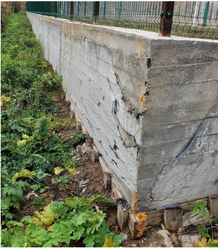
Фото 25. С бетонной подпорной стены спортивной площадки не была демонтирована дощатая опалубка, а просто для скрытия дефекта присыпана грунтом.
