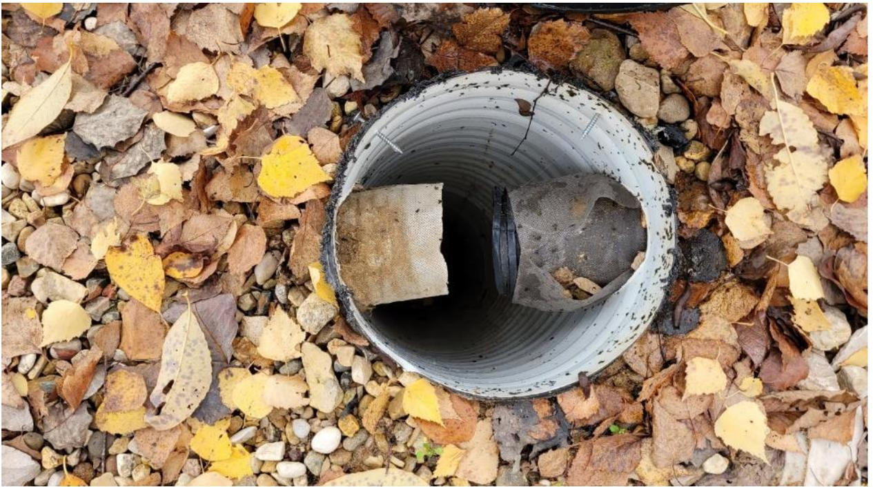
Фото 19. Вводы дренажных труб в смотровые колодцы не уплотнены специальными манжетами. Из-за допущенного дефекта грунты свободно вымываются в смотровые колодцы и забивают их.
