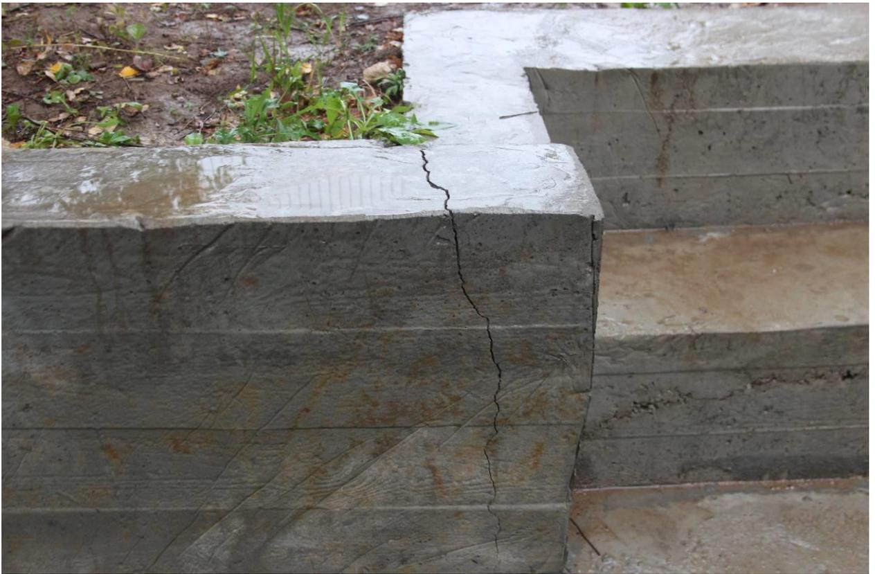
Фото 3. Сквозная вертикальная трещина подпорной стены у детской площадки
