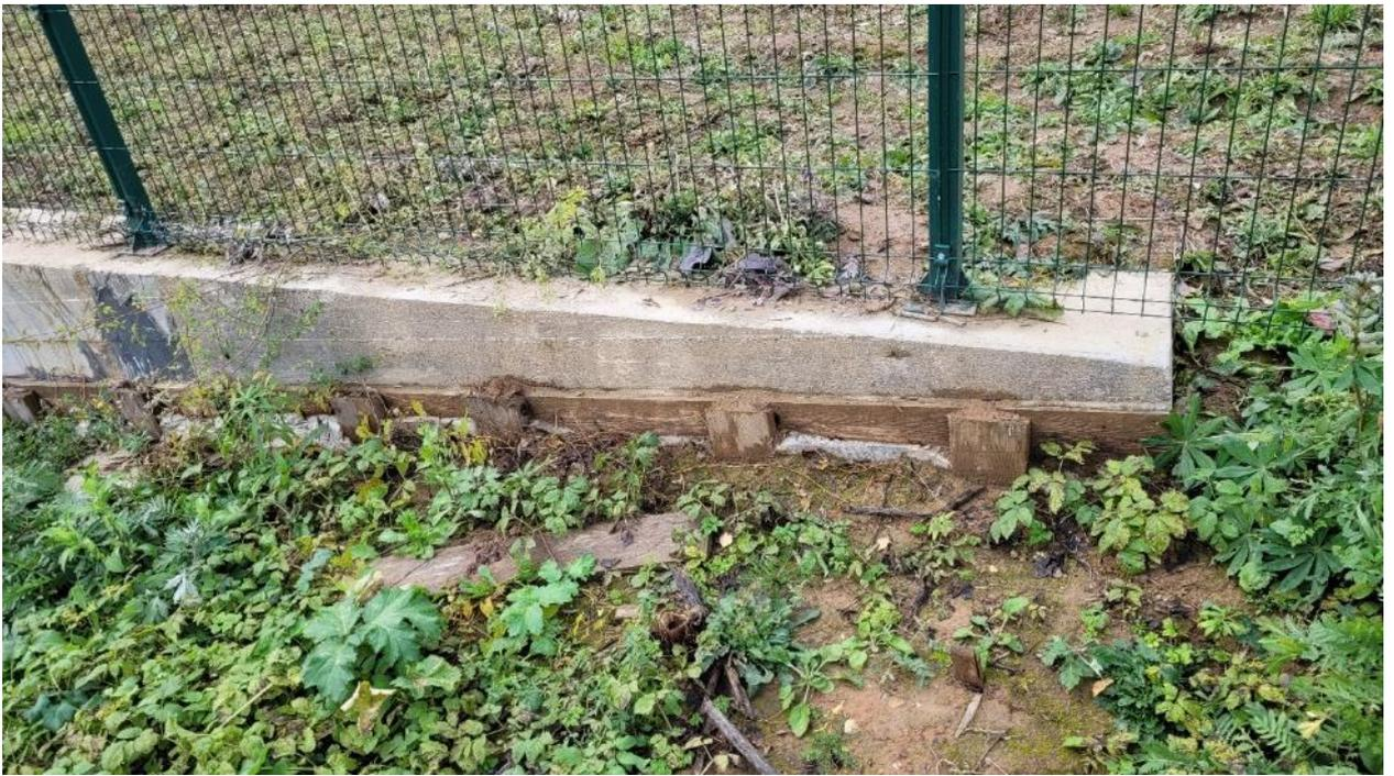
Фото 23. С бетонной подпорной стены спортивной площадки не была демонтирована дощатая опалубка, а просто для скрытия дефекта присыпана грунтом.
