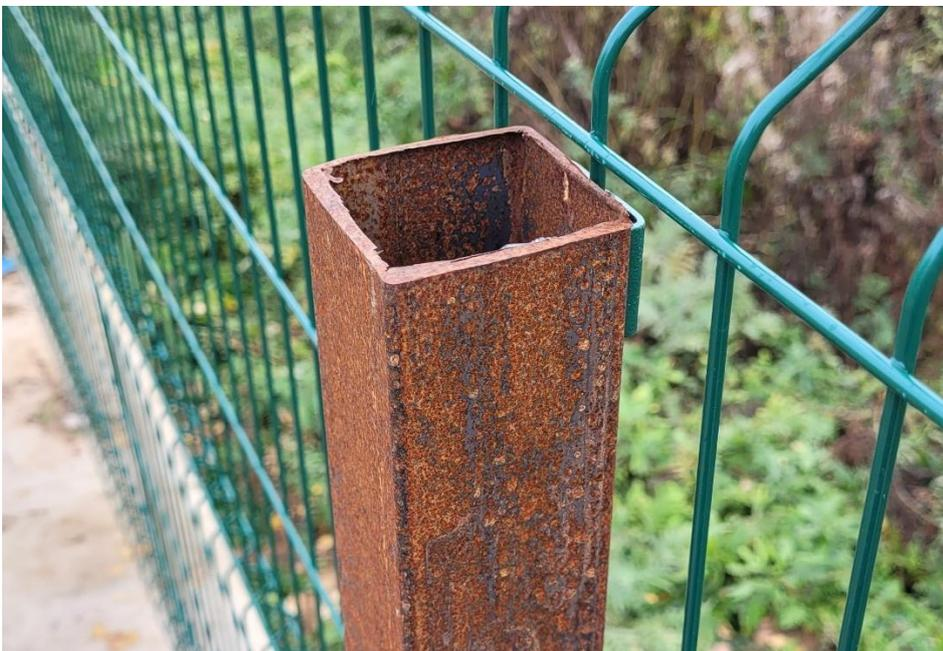
Фото 16. Открытые торцы профильных труб не имеют специальных герметичных заглушек, трубы не окрашены.
