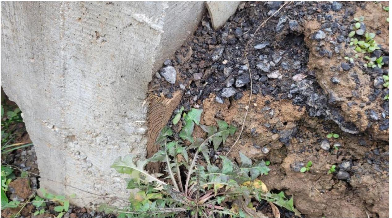
Фото 9. На поверхности бетонных оголовков повсеместно образованы крупные раковины, деревянная опалубка не была своевременно демонтирована с оголовков, а просто присыпана грунтом для скрытия дефекта.
